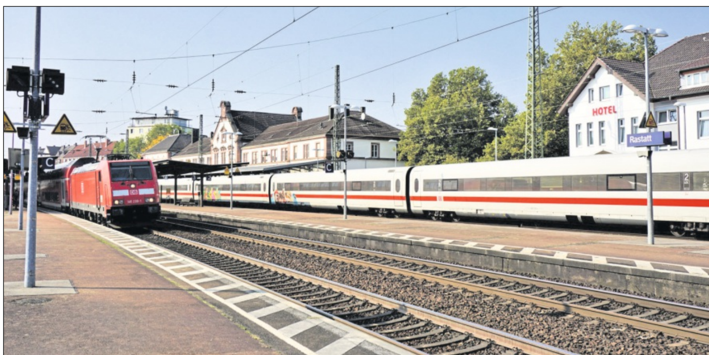
FÜR HISTORISCHE FILME bietet der Rastatter Bahnhof eine ausgezeichnete Kulisse – aber das soll sich ändern, wenn die Station saniert und behindertengerecht ausgebaut wird. Fotos: Collet
