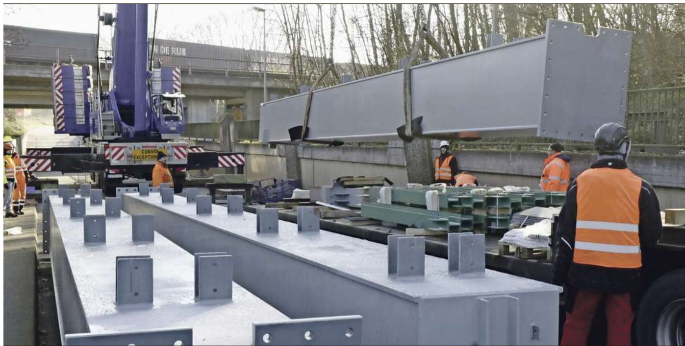
Ein 400-Tonnen-Kran ist notwendig, um den „Torsionsbalken“ an seinen Ort zu hieven.
