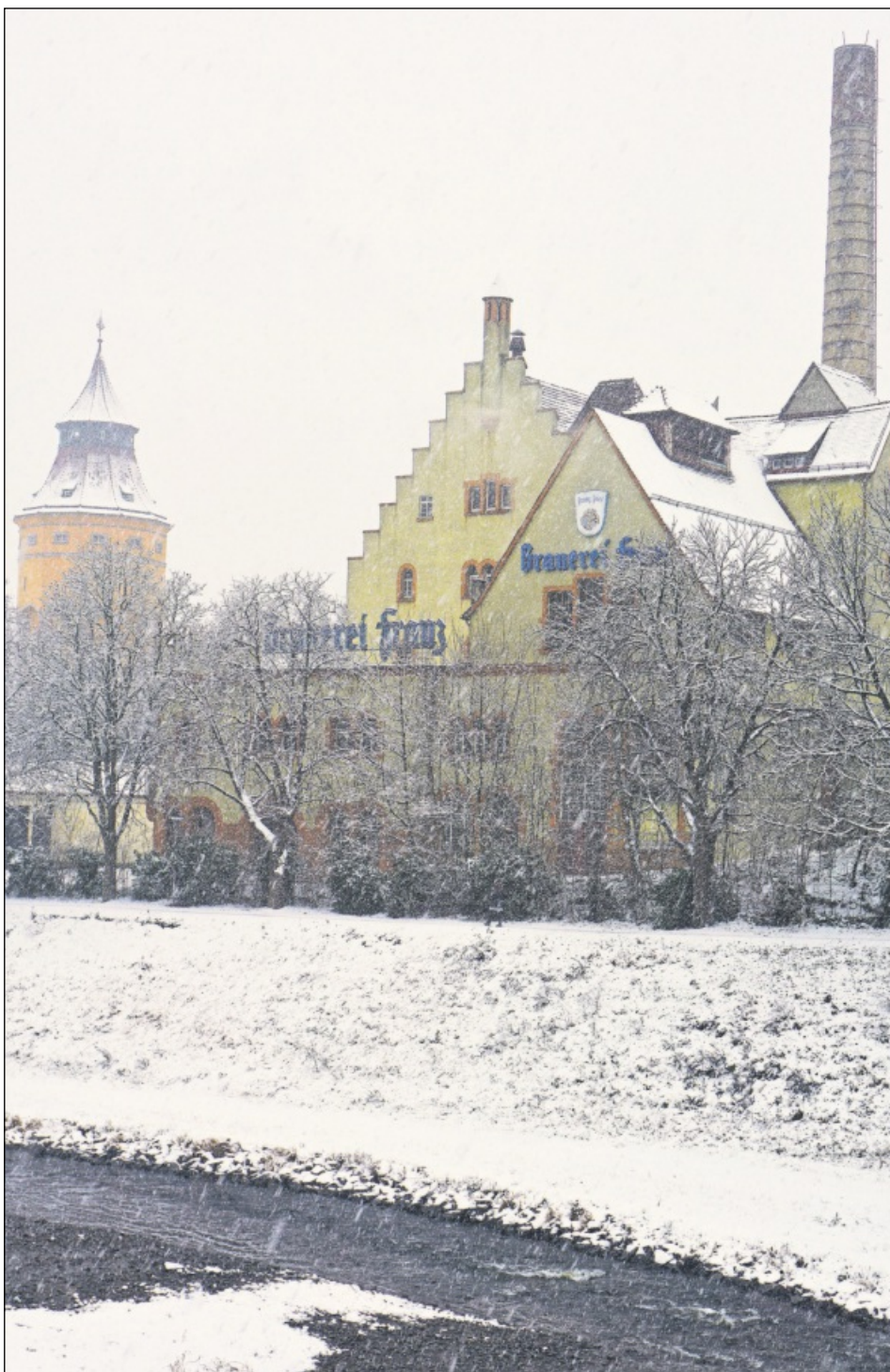
BEI DER FRANZ-BRAUEREI sollen nach der Jubiläumsfeier am 3. Oktober die Abrissarbeiten für den Hotel-Neubau beginnen. Foto: Collet
