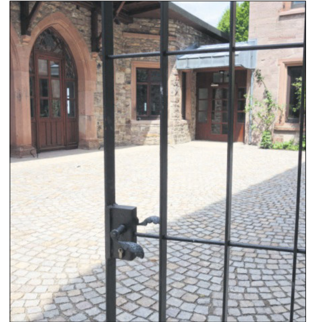
PFLASTER statt Betonsteine und ein barrierefreier Eingang zum künftigen Restaurant zieren schon jetzt den Hof.
